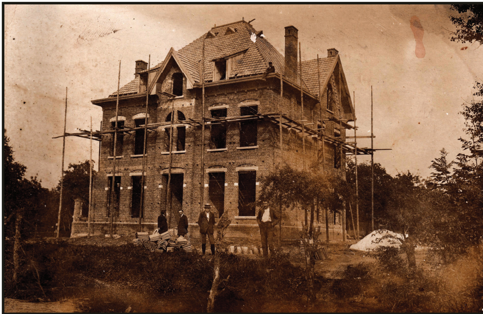
Een huis, dat Frans als aannemer bouwde.
